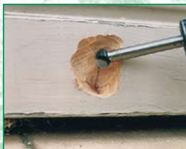
verwijderen van losse kwasten
