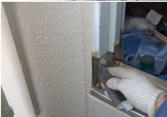
④密着を上げるため研磨、特に鉄部内側
