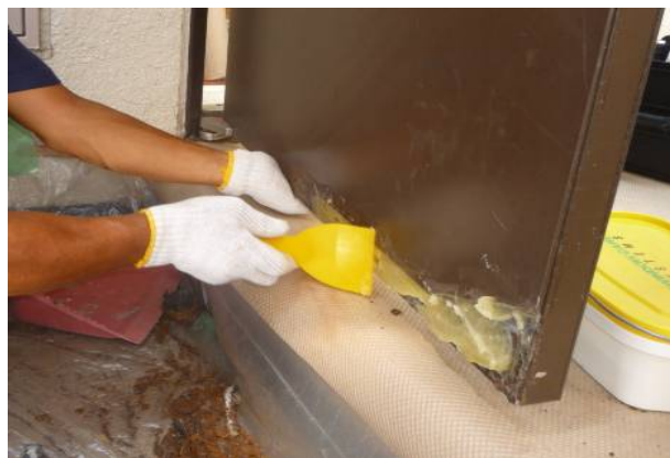
ドライフレックス®4で厚付け成形する
