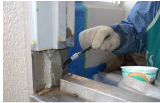
⑤ドライフィックス®4をモルタル部に塗布。
