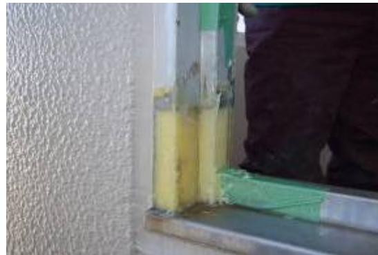
⑥エアを残さないよう押し込みながら薄付け
