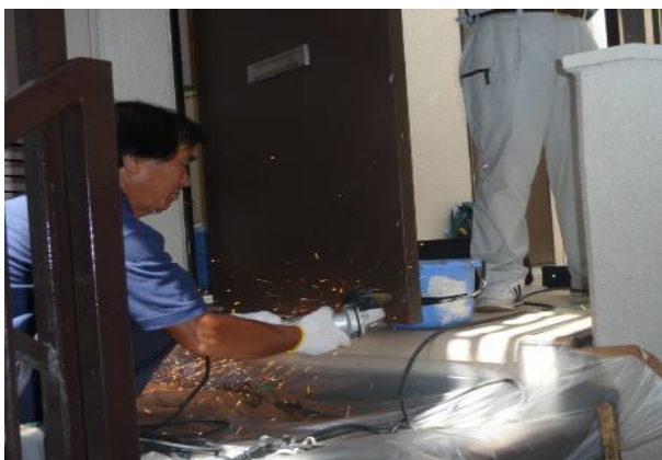
腐食部分を完全に除去する(密着に影響する為)
