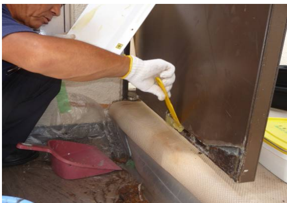
ゴミや汚れを除去後、ドライフレックス®4充填 エアを残さないよう、まず薄付けで押し込む*
