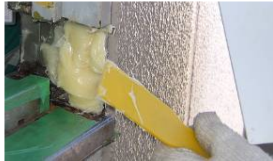
⑥エアを残さないよう押し込みながら薄付け
