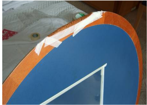
ドライフィックス®（プライマー）を塗布。 20分浸透させる。20分後、浸透せず表面に残ったプライマーは必ずウエス等でふき取る。
