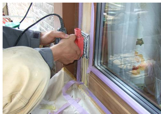
硬化後、ペーパーサンダーで表面を平滑にする。 この一手間で表面がツルツルの平面になります。
