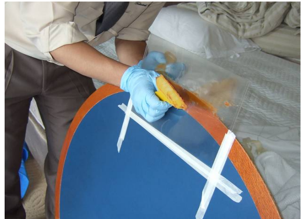
塗装後下地の色が影響しないよう、あらかじめドライフレックス®を調色して充填する。 押し込みながらエアを抜くこと。
