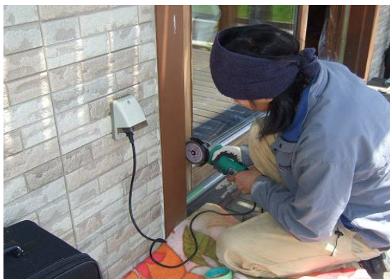
カッターで補修箇所を10 x 10mmはつる
