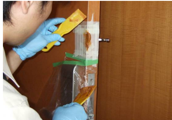
塗装後、下地の色が影響しないようあらかじめ調色下ドライフレックス®を充填する。プライマーとの間にエアを残さないよう注意。
