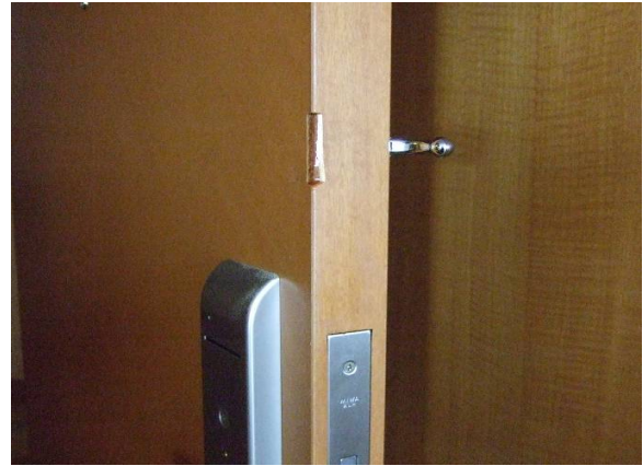
ドライフィックス®(プライマー)を塗布。20分浸透させ、後に表面に残った余剰分はふき取る。
