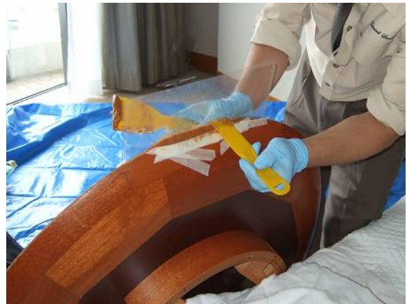
充填作業。反対側から見たところ。
