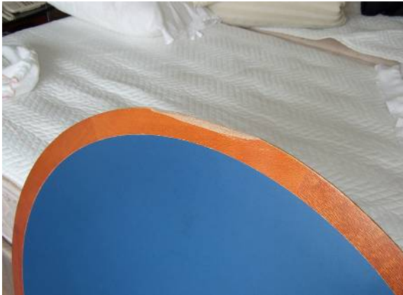
客室に設置されたテーブルの欠損。
