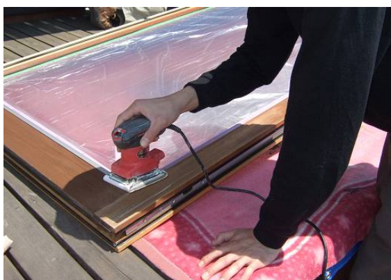
補修面の塗膜をペーパーサンダーで除去する
