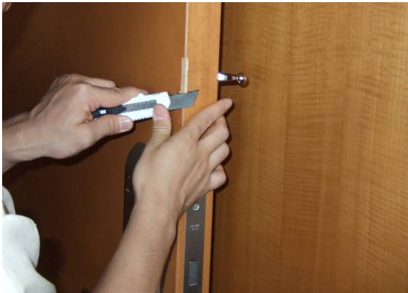
接着面確保のため10mmx10mm程にはつりを入れる。
