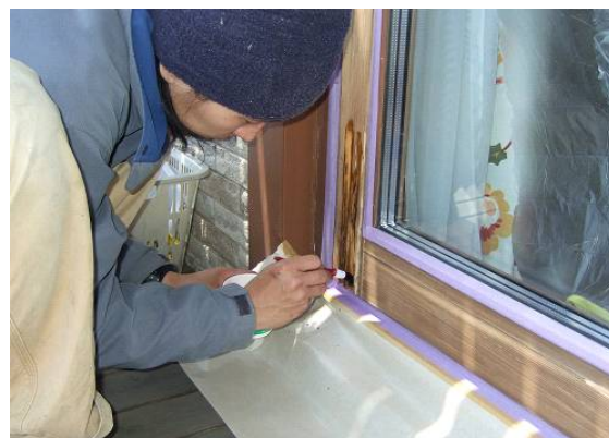
プライマー処理をする
