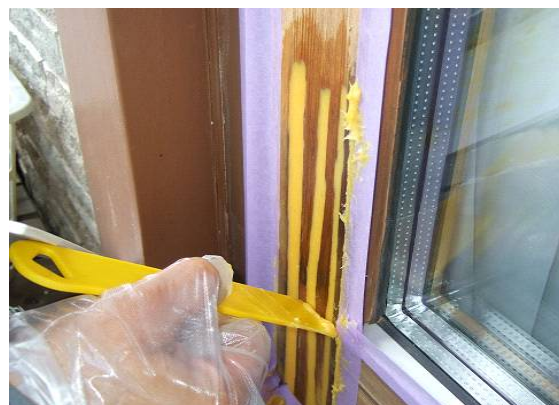
ドライフレックス®で充填成形する
