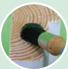
2e laag aanbrengen
