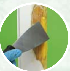
DRY FLEX® 1 aanbrengen
