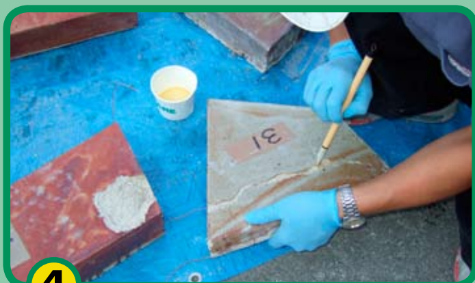
ドライフィックス®を補修箇所に塗布。塗布20分後、浸透しない余剰分をウエス等でふき取る
