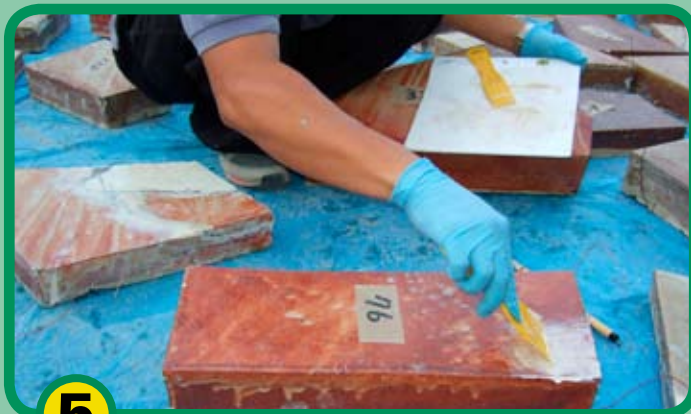
ドライフレックス®を充填・成形する プライマーとの境目にエアを残さないよう注意
