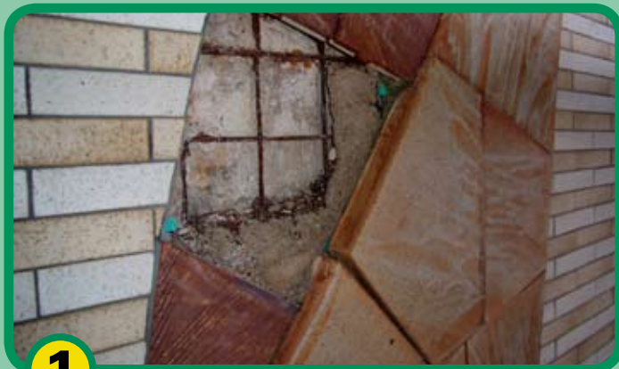
高校外壁の陶板製モニュメント 接着部の劣化が見られる
