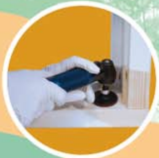
1. Alte Beschichtung entfernen
