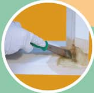
4. Reparaturkontaktstellen mit DRY FLEX® schließen
