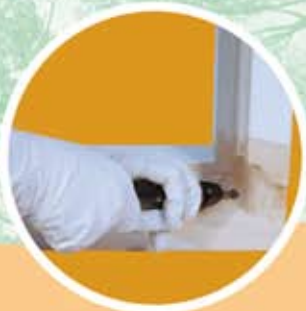
2. Beschädigtes Holz abtragen
