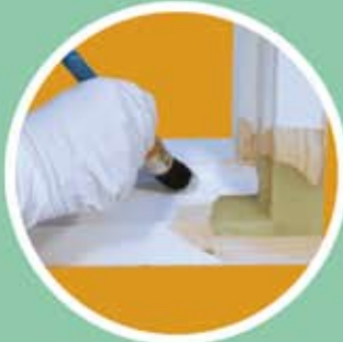
7. Beschichtungssystem auftragen
