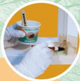
3. Reparaturkontaktstellen mit DRY FIX® festigen
