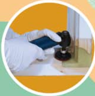
6. Ausgehärtetes DRY FLEX® schleifen
