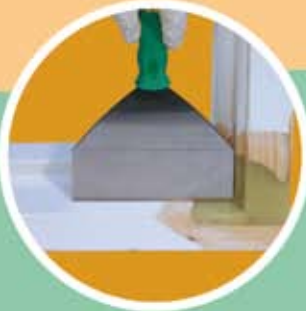
5. DRY FLEX® abziehen und modellieren
